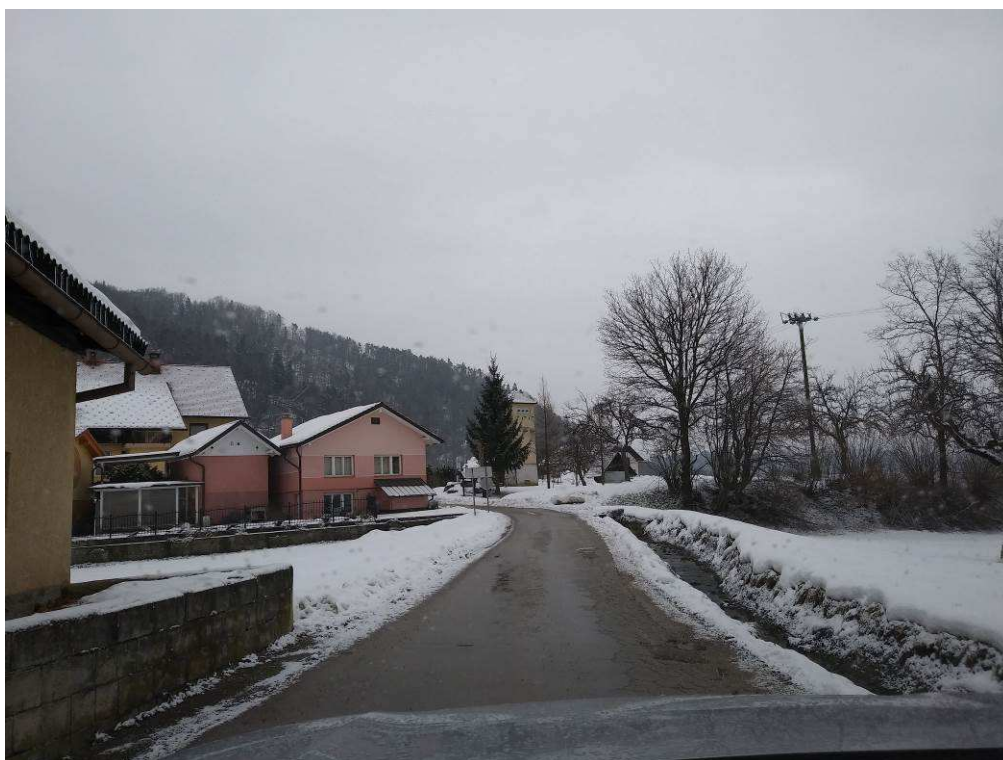
Slika 5: Pogled na traso
